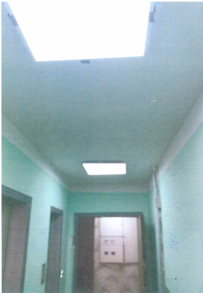
Фото после монтажа светодиодных светильников
